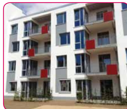
Blick Innenhof, Körnerstraße 46
