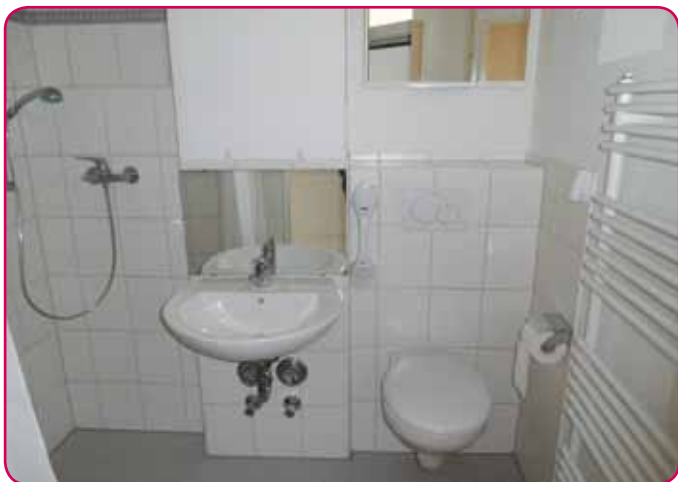
Barrierefreiheit: Ein Badezimmer in einer der Wohnungen im Krummenacker nach dem Umbau durch die GEWOBA.
